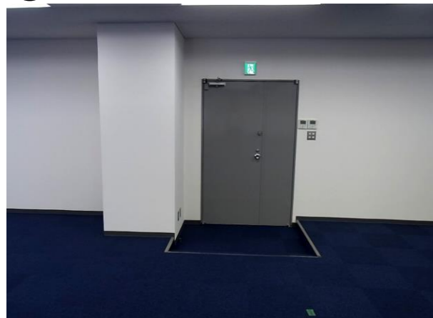
出入口A扉
