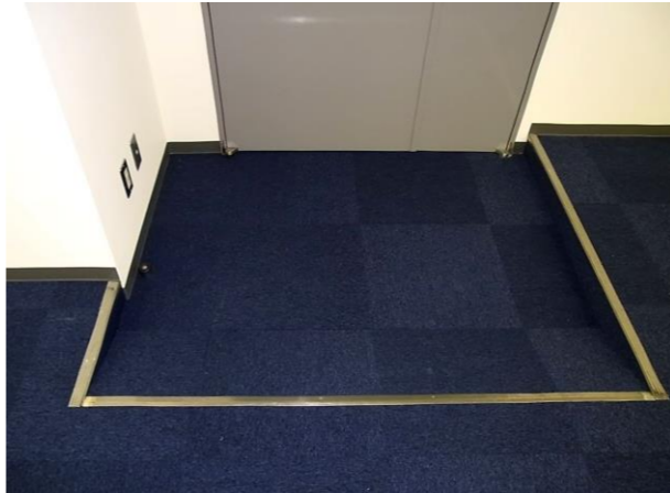
出入口A扉スロープ
