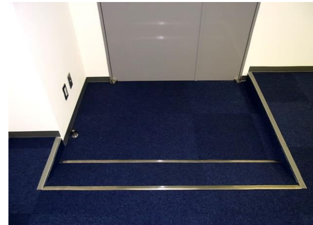
出入口B扉スロープ
