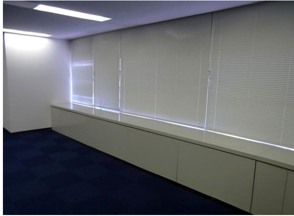
南東側ブラインド新設
